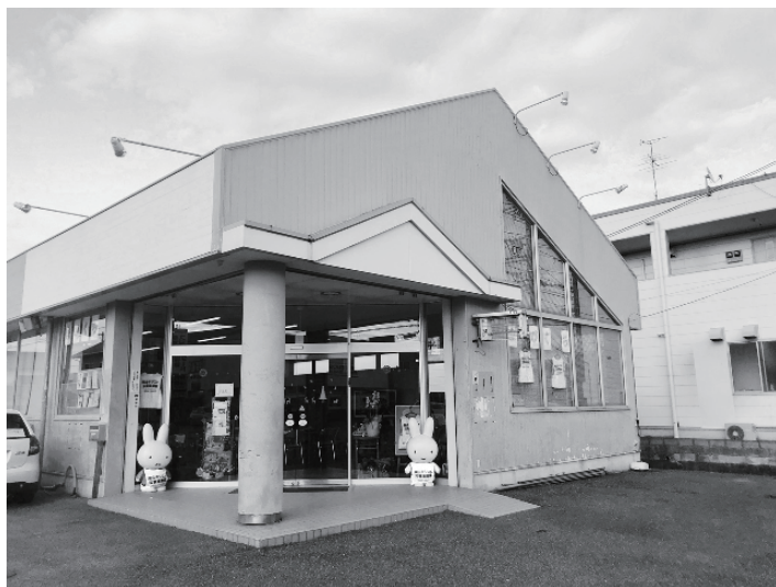
<まびくら>の外観
