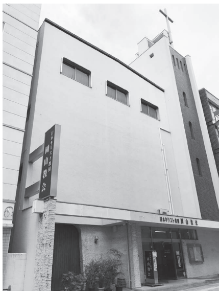
岡山教会 外観
